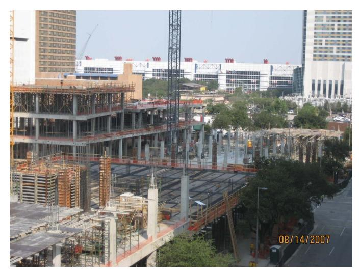
**BLOCK 273** - OFFICE TOWER 2<sup>ND</sup> LEVEL CONCRETE SLAB IN FOREGROUND. FRAMING FOR 3<sup>RD</sup> LEVEL OF THE TOWER HAS BEGUN.
